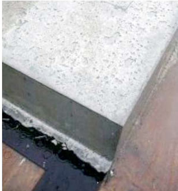
Photo 5 : l'encorbellement négatif étant coulé « en aveugle », un plot de convenance a été conçu, permettant de valider la formulation du béton spécifique, sa bonne mise en œuvre et sa prise
