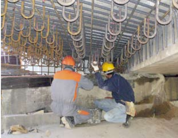
Photo 3 : les scellements en plafond de liaison de l'encorbellement négatif à l'encorbellement positif existant (Avec des zones difficiles d'accès au niveau des sommiers des culées existantes)
