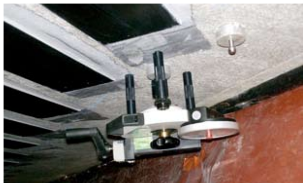
Photo 7 : essai d'arrachage de pastilles pour valider l'adhérence des lamelles. Avec des résultats difficiles pour les zones ragrées – Source : Hervé Marneffe (CETE de l'Est)
