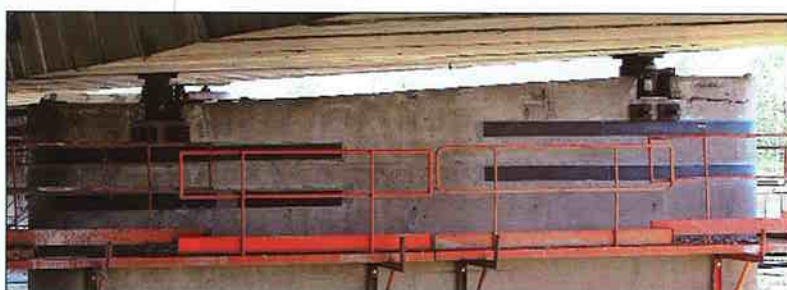
Photo 18 Vue sur une pile latérale après vérinage de 50 mm A side pier after jacking by 50 mm
